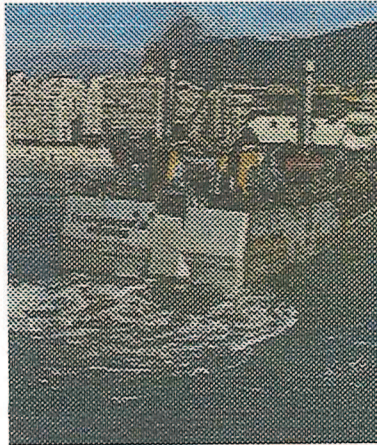
Figura 1: Ação de dragagem para alimentação artificial na Praia de Copacabana (engorda) na década de 60.
