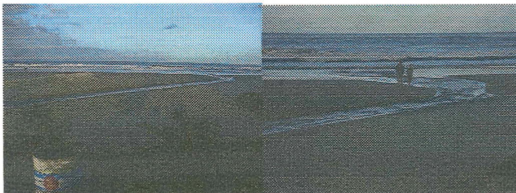
Figuras 38 e 39: Balneário Caiobá, cuja estrutura urbana apresenta aspectos de erosão em determinados pontos da porção central.
