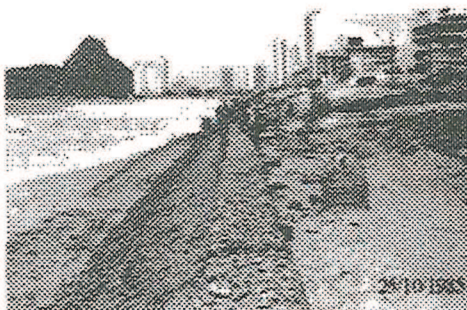
Figura 12 e 13: Erosão na praia Brava de Caiobá e a tentativa de construção de muro de contenção (1985) e resquícios dos gabiões colocados na praia Brava de Caiobá (que já não mais estão aparentes).
