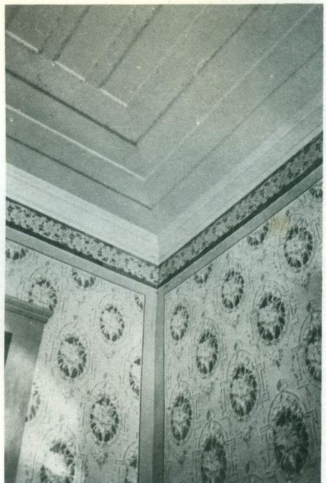
Detalhes do forro em duas salas frontais do corpo central do Casarão. O tabuado é do tipo "saia e camisa" com cimalha (arremate horizontal). Observa-se também a pintura das paredes. 1984.
