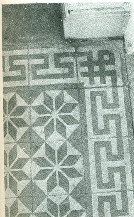
Detalhe do ladrilho hidráulico do piso da varanda frontal. Desenho de flores estilizadas emolduradas por uma barra geométrica. 1984.
