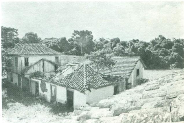
Vista geral do conjunto de edifícios que delimitam o pátio frontal do Casarão: casa do capataz, depósito de arreios e cocheira. Misturam-se aí a taipa de pilão, a alvenaria de tijolos e a madeira. 1985.
