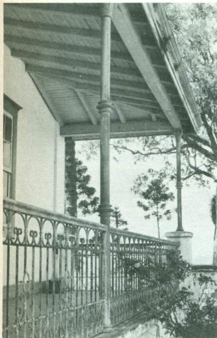
Detalhe da varanda frontal, com suas colunas e gradil de ferro típicos do final do século 19. Os condutores das águas pluviais são embutidos nas colunas. 1984.
