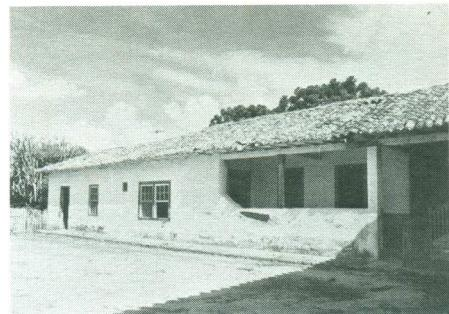
No prolongamento da varanda, observa-se as unidades de serviço: cozinha, depósitos, etc. Nota-se a parede, em taipa de pilão, recortada a meia altura, ampliando a comunicação com o grande pátio de serviços. 1984.
