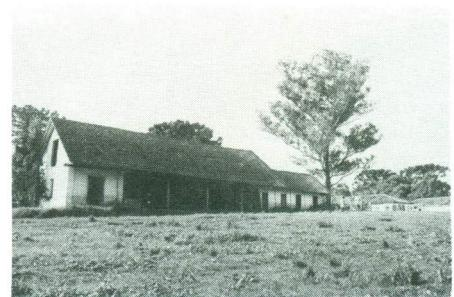
Fachada norte do grande celeiro à esquerda do Casarão. O edifício foi construído em alvenaria de tijolos e coberto com telhas francesas. 1982.
