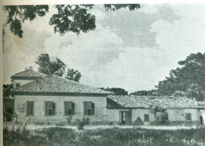
Fachada lateral sul. Quatro grandes janelas, e os cunhais salientes, delimitam o corpo central. Observa-se o perfil da varanda frontal, com abertura independente e o mirante. Atrás, uma parte da face externa do apêndice de serviços. 1982.
